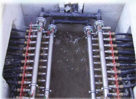
FASE 4: COLLEGAMENTO CONNESSIONI A COLLETTORI
